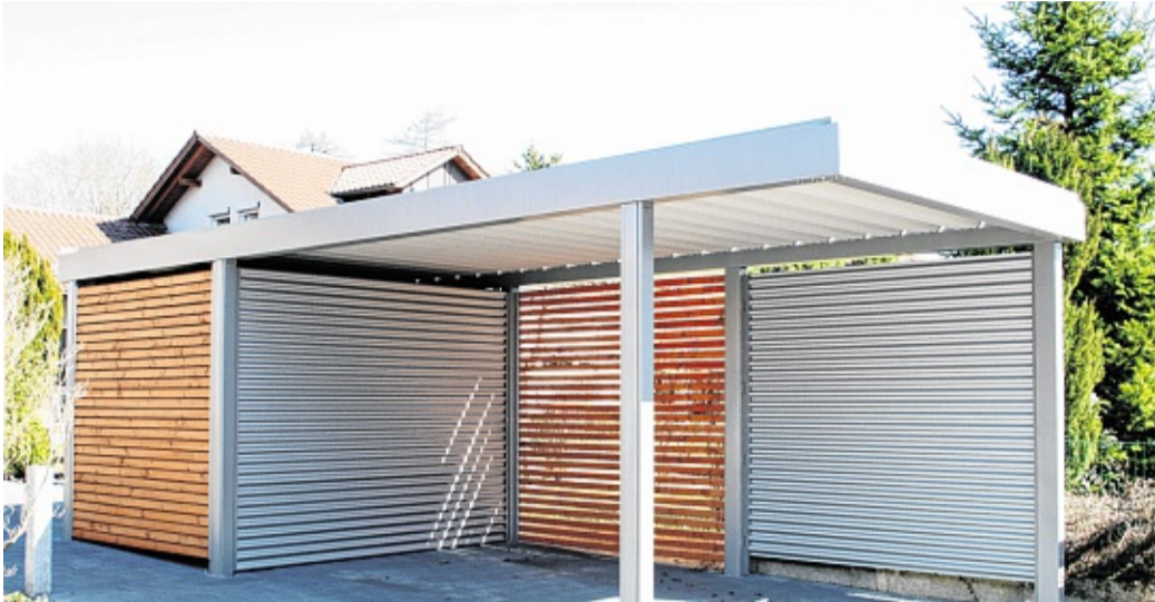
Der Carport bietet viel Platz für Auto und Gartengeräte.
